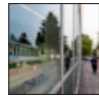
s 12 Foto: Tine Poppe, Forsvarsbygg. Glassfasaden på messebygget på KNM Harald Haarfagre, Madla
